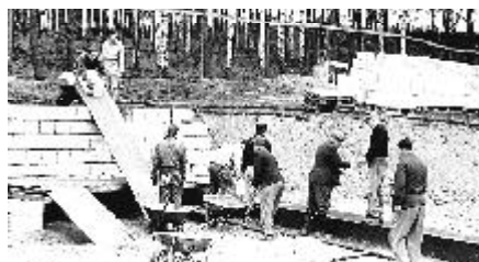
Základy už jsou, tak teď se začíná s hroubou stavbou
